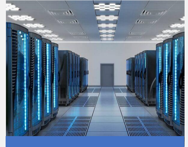
مشروعات مراكز البيانات (Data Centers)
